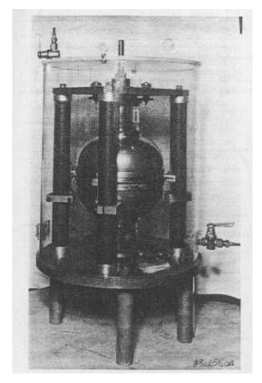
1950年代通用电气公司在真空灭弧室发展方面取得的成就体现在那篇著名的论文"电力用真空灭弧室
