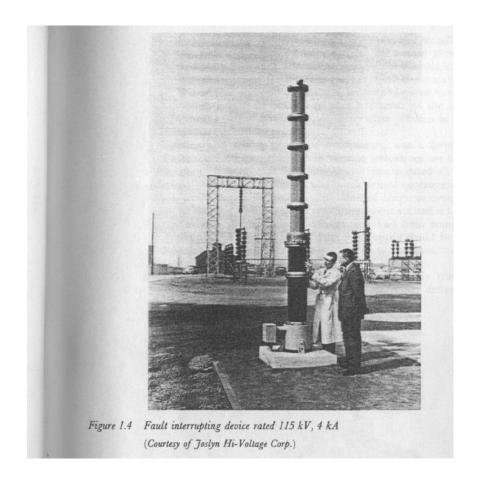
1959年出现了一个叫作故障切断器的真空开关装置,由螺线管操动,额定电压115kV,额定电流600A,额定短路开断电流4000A,由5个Jennings公司的真空灭弧室串联组成。这个装置被用于美国新奥尔良公用电网。
