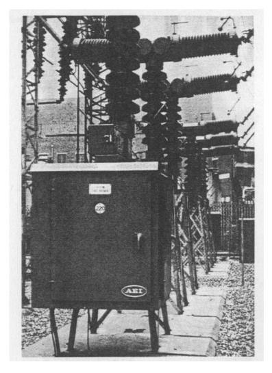
英国联合电气工业公司也认为真空断路器的发展方向在高压和超高压等级。在1967/68年他们制造并出售了4台132kV额定短路开断电流16kA(3500MVA)的真空断路器。
